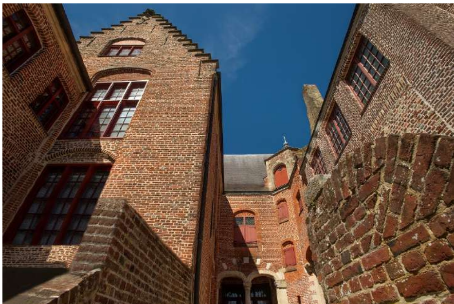
Vue de la façade arrière du musée de Flandre © Dominique Silberstein
